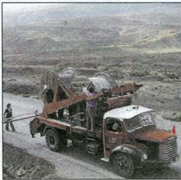
24.8. Прокладка кабеля в пустыне
