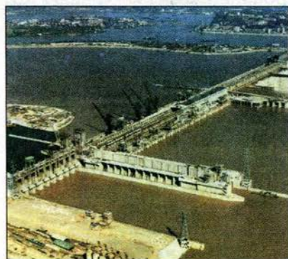
58.3. Гидроузел на одной из рек Китая
