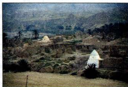
61.2. Арабские глинобитные постройки
